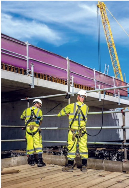
Abb. 2: Das Verbindungsmittel DSL (links) passt seine Länge der jeweiligen Arbeitssituation flexibel an.
