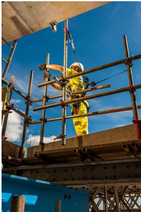
Abb. 1: Das DSL2 kombiniert die Vorteile von Höhengsicherungsgeräten und Verbindungsmitteln mit Bandfalldämpfer.
