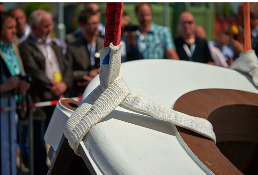
Abb. 7: Das Gehäuse wird mit 2 Rundschlingen Magnum-X im Schnürgang angeschlagen. Die Rundschlingen sind ausgestattet mit einem NoCut-Schlauch.
